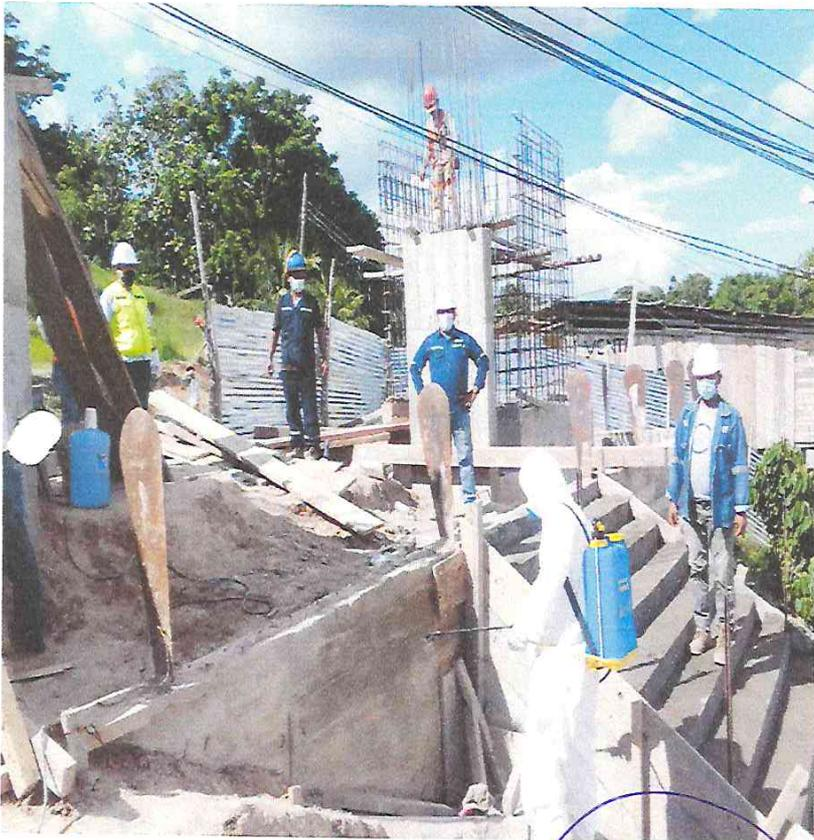
EN LA IMAGEN SE NOTA LA COLOCACION DE ACERO Y EL ENCOFRADO DE PORTADA PRINCIPAL, VERIFICADO POR EL SUPERVISOR Y RESIDENTE
